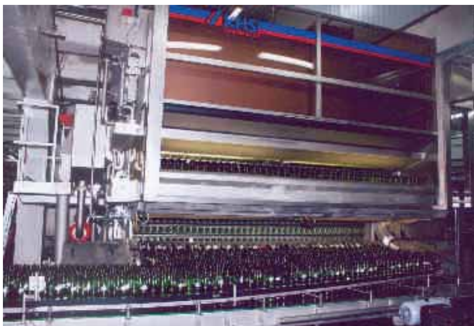
Jeder Zentimeter Platz wurde in der neuen KHS-Glaslinie optimal genutzt. Beispielsweise ist die Einend-Flaschenreinigungsmaschine zwischen zwei bestehenden Säulen eingepasst. Etiketten- und Scherbenaustragungen, Pumpstationen und viele weitere Aspekte mehr wurden exakt auf die spezielle Raumsituation hin ausgerichtet.
